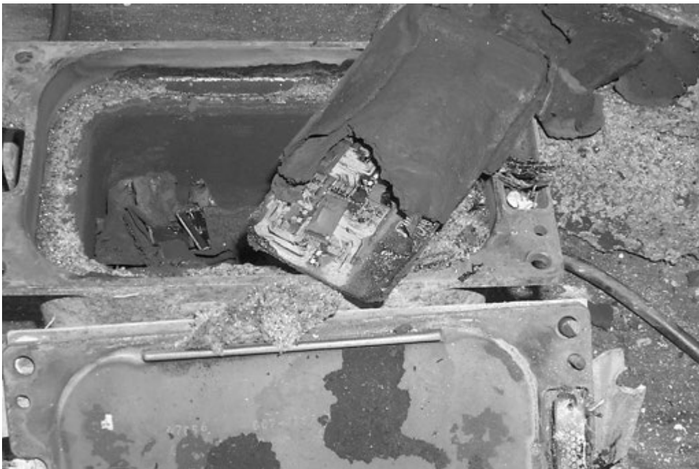
Figure III-7-3. Support d'enregistrement endommagé
